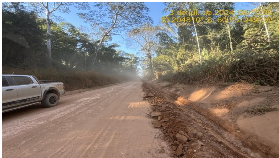
Escavação Mecânica de Vala Material de 1ª Categoria – Rodovia MT-313, km 200,60.
