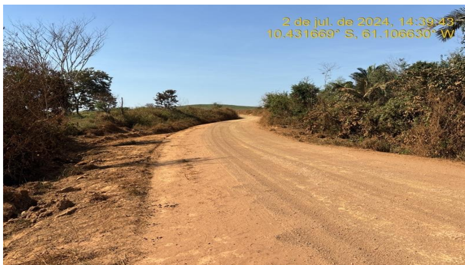
Reconformação Plataf., Escavação mec. vala mat. 1ª cat. e Regularização mec. faixa domínio – Rodovia MT-313, km 86,90.
