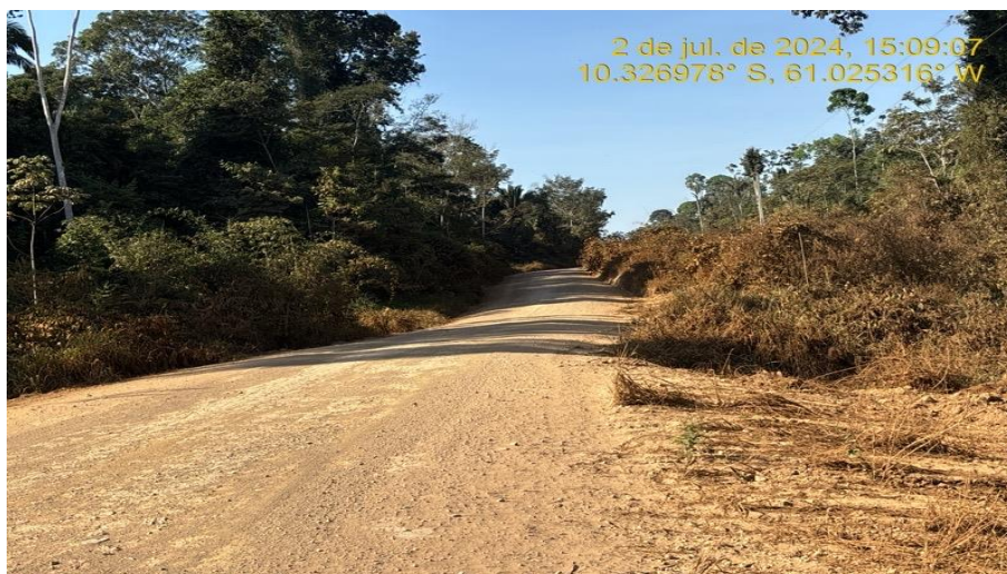
Reconformação Plataf., Escavação mec. vala mat. 1ª cat. e Regularização mec. faixa domínio – Rodovia MT-313, km 102,10.
