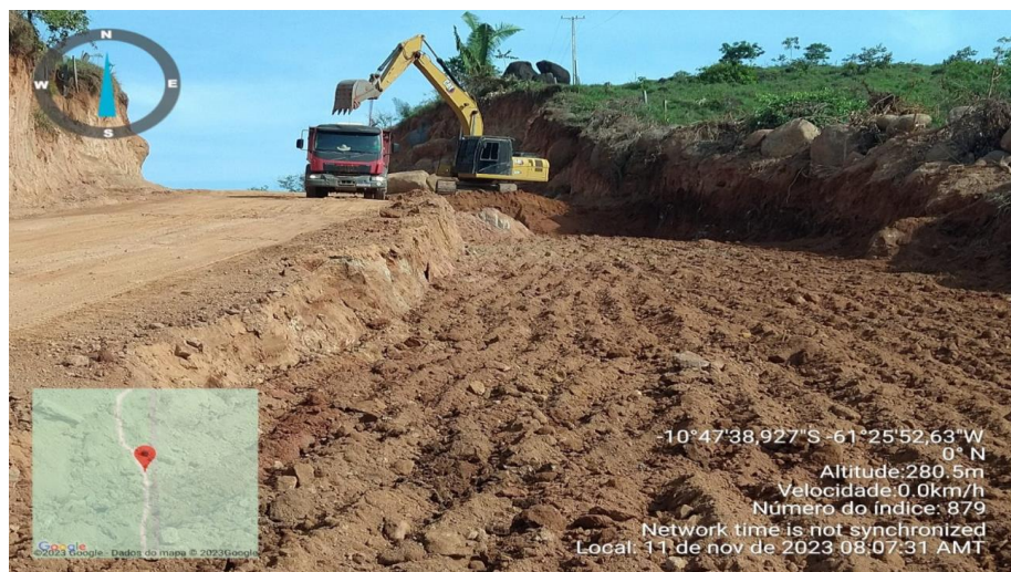
Escavação, carga e transporte 1ª categoria até 3.000m – Serra Rondolândia – Rodovia MT-313, KM 7,20.
