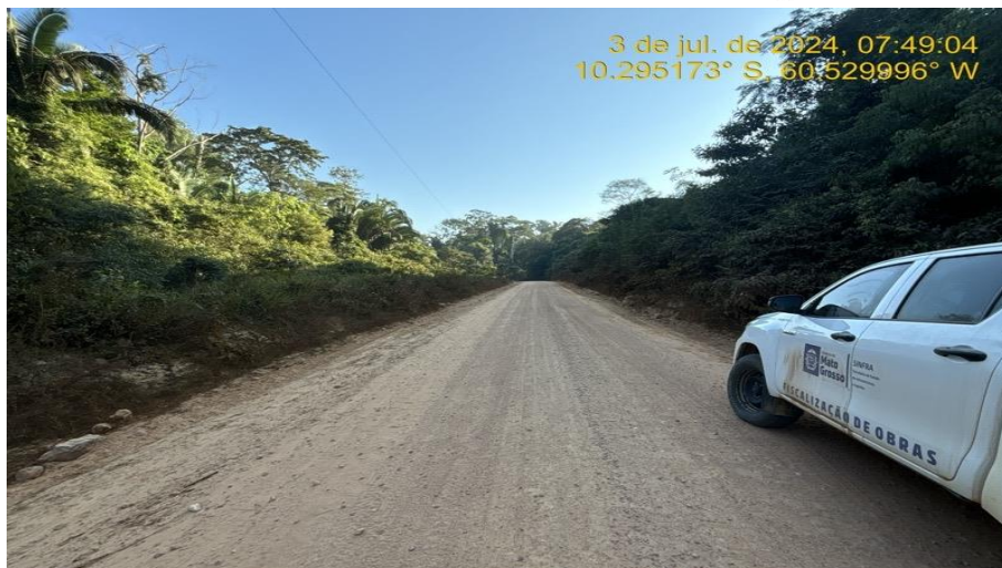
Reconformação da Plataforma, e Regularização mecânica de faixa domínio – Rodovia MT-313, km 189,80.
