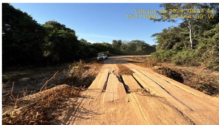
Ponte de Madeira, futura instalação de Aduela – Rodovia MT-313, km 204,53.
