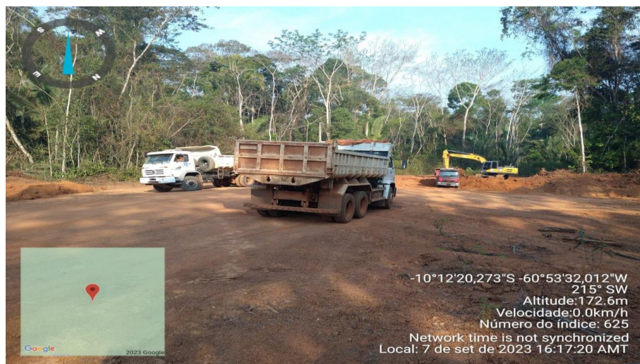
Escavação, carga e transporte 1ª categoria até 3.000m – Jazida (Cascalho) – Rodovia MT-313, KM 123,40.
