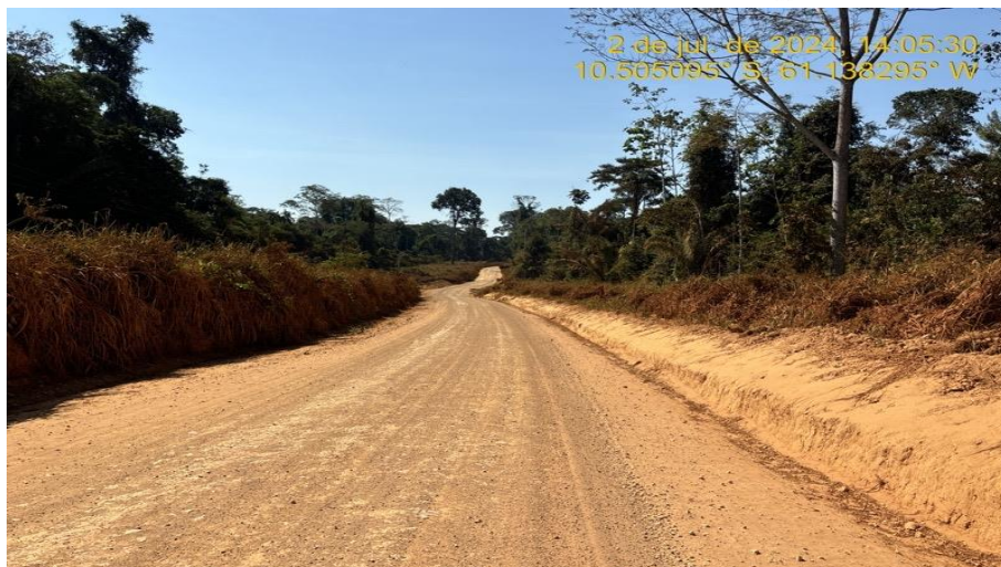
Reconformação Plataf., Escavação mec. vala mat. 1ª cat. e Regularização mec. faixa domínio – Rodovia MT-313, km 76,30.
