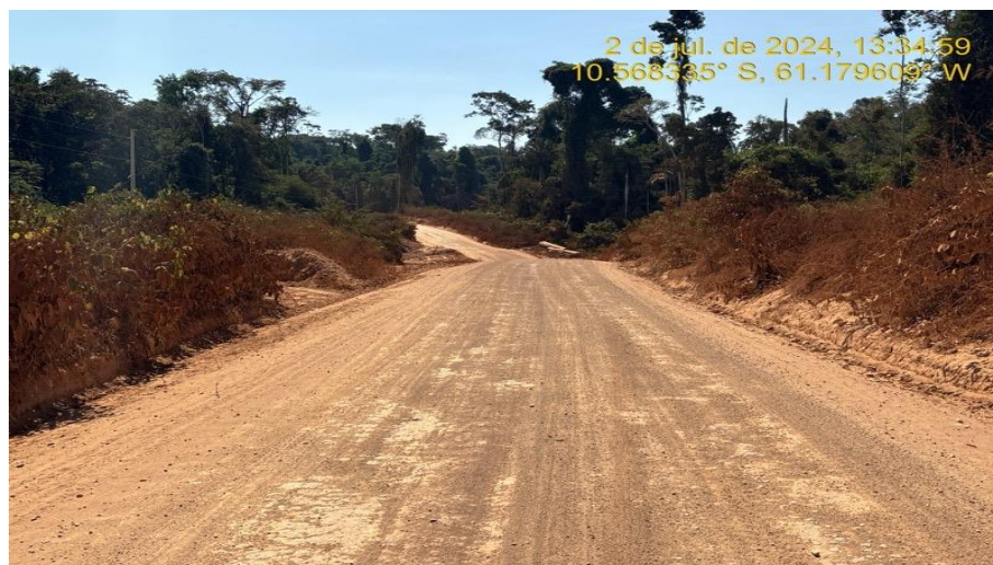
Reconf. Plataf., Escav. mec. vala mat. 1ª cat. e Regularização mec. Faixa dom. – Rodovia MT-313, km 67,10.
