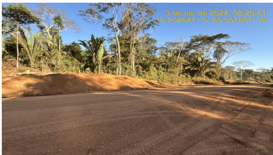
Caixa de Empréstimo Lateral (Jazida de Cascalho) – Rodovia MT-313, km 200,85.
