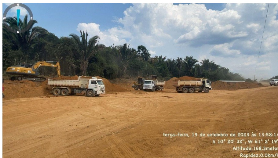
Escavação, carga e transporte 1ª categoria até 3.000m – Jazida (Cascalho) – Rodovia MT-313, KM 99,80.
