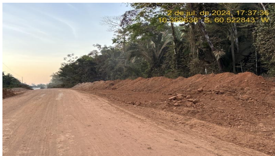
Caixa de Empréstimo Lateral (Jazida de Cascalho) – Rodovia MT-313, km 181,10.
