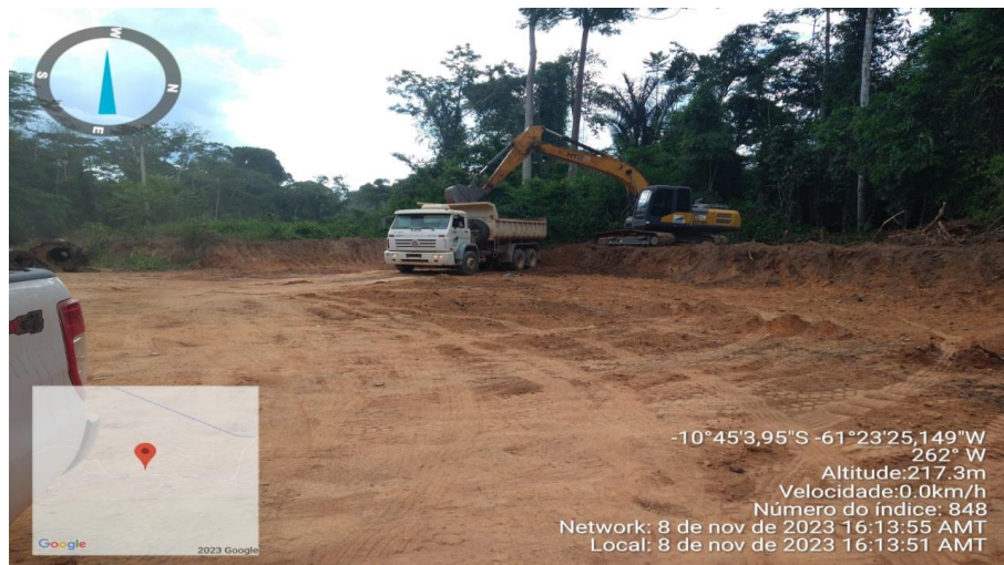
Escavação, carga e transporte 1ª categoria até 3.000m – Jazida (Cascalho) – Rodovia MT-313, KM 22,50.
