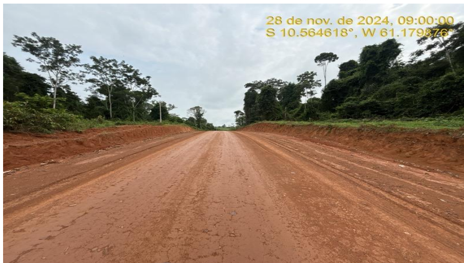
Reconformação Plataforma – Escavação mecânica de vala em material de 1ª Categoria – Regularização mecânica da faixa de domínio – Rodovia MT-313 – ASSOCIAÇÃO APROVALE.
