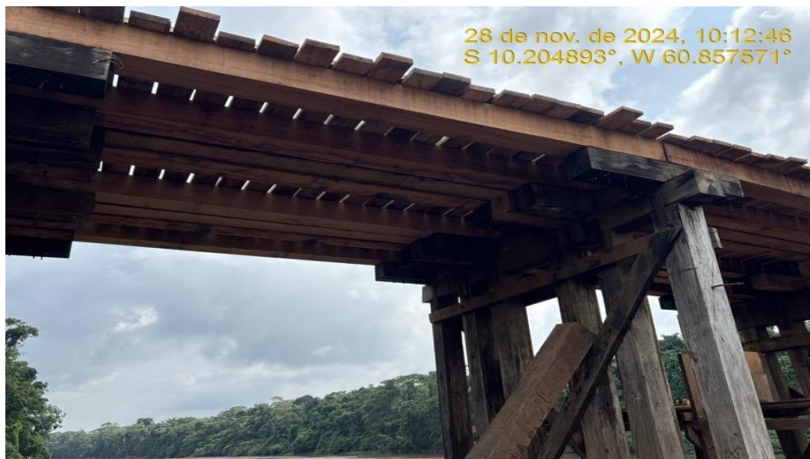
Reforma de Ponte de Madeira sobre o Rio Branco – Rodovia MT-313 – ASSOCIAÇÃO APROVALE.
