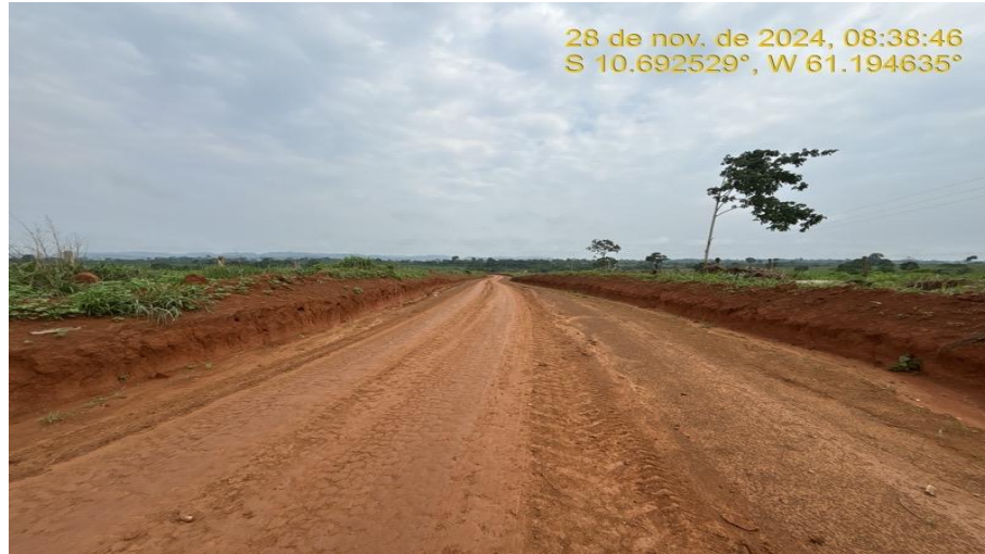
Reconformação Plataforma – Rodovia MT-313 – ASSOCIAÇÃO APROVALE.
