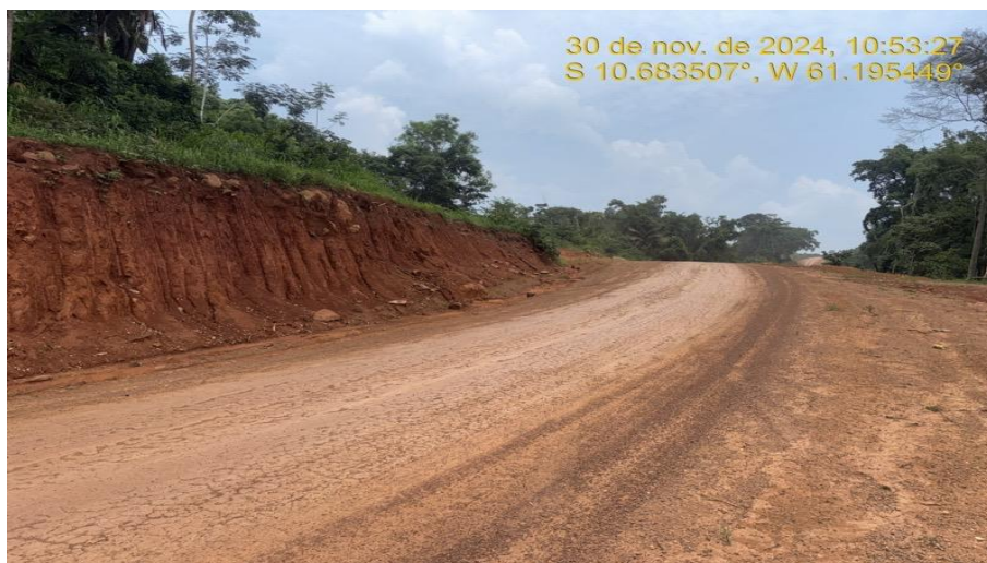
Reconformação Plataforma – Escavação, Carga e Transporte de 1ª categoria – Regularização mecânica faixa domínio – Rodovia MT-313 – ASSOCIAÇÃO APROVALE.
