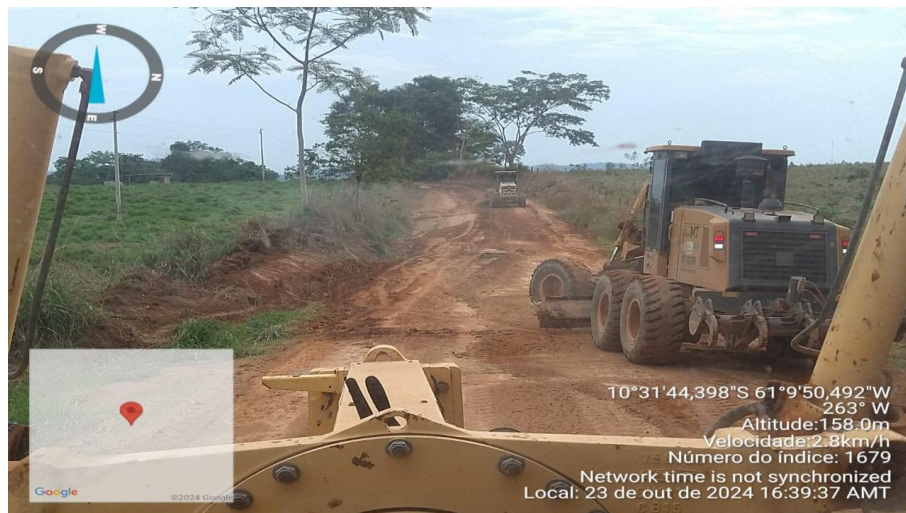
Reconformação da Plataforma – Rodovia MT-313 – ASSOCIAÇÃO APROVALE.
